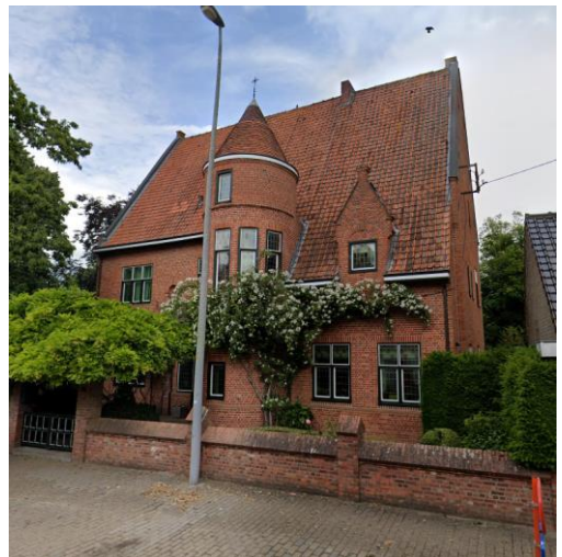
Foto 4: Voormalige pastorie in een ommuurde tuin
