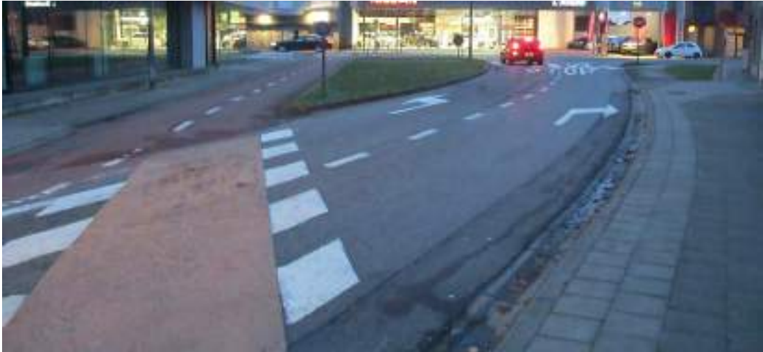
Figuur 54: Fietspad in Sportstraat nabij Haiglaan (Eigen foto, februari 2019)
