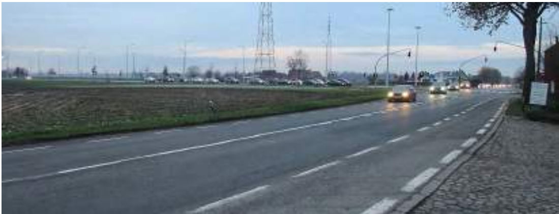
Figuur 65: N8 (Veurnseweg) richting het kruispunt met N38 (Noorderring) (Eigen foto, februari 2019)
