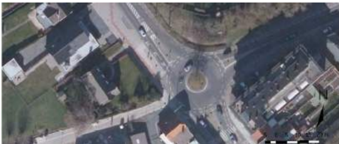
Figuur 118: Bestaande situatie van rotonde N8 – Haiglaan (Orthofoto, februari 2019)
