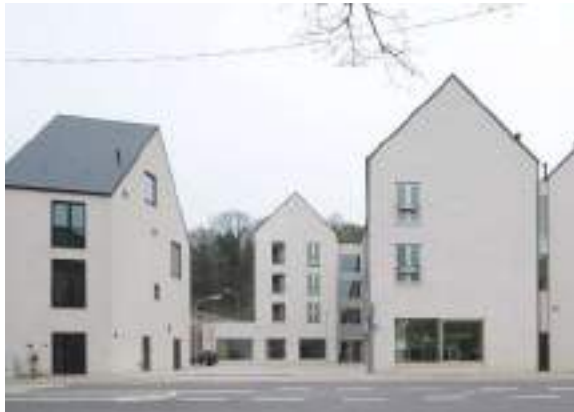
Figuur 60 OCMW Aarschot, dvt i.s.m. DRDH architects
