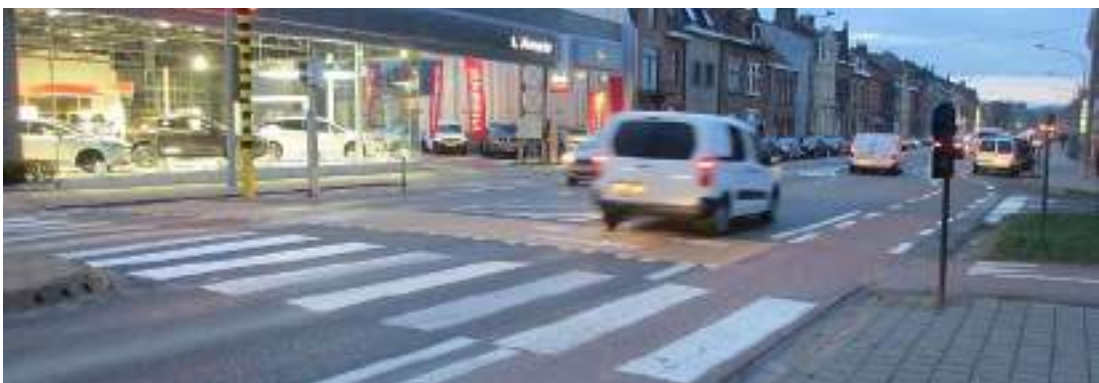
Figuur 53: Oversteekplaats in Haiglaan nabij Sportstraat (Eigen foto, februari 2019)
