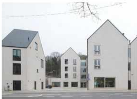
Figuur 60 OCMW Aarschot, dvtv i.s.m. DRDH architects
