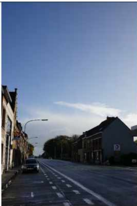
Foto 1: steenwegontwikkeling Meenseweg/N8: westelijk deel – cluster van zeven aaneengeschakelde woningen
