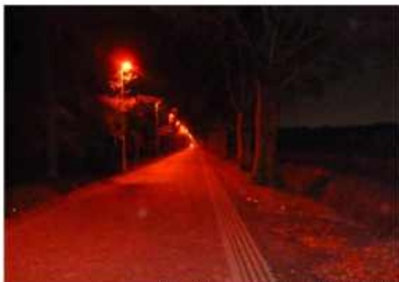
Figuur 37 vleermuisvriendelijke led verlichting
