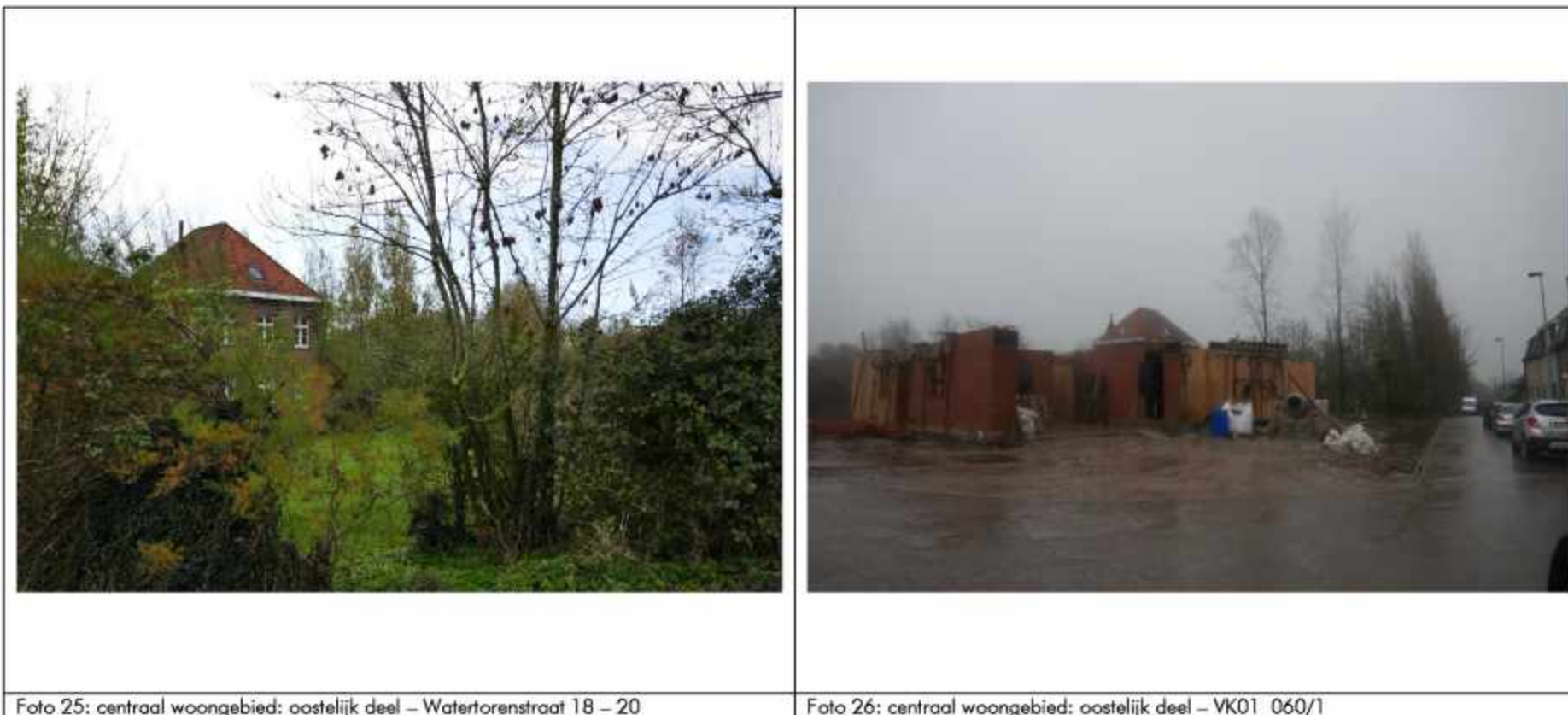
Foto 25: centraal woongebied: oostelijk deel – Watertorenstraat 18 – 20
