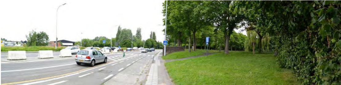
Figuur 3-7 Confrontatie tussen de Oudstrijderslaan en het Vredespark – een potentiële poort naar de vestingen, echter op vandaag zonder een rechtstreekse fysieke link ernaartoe
