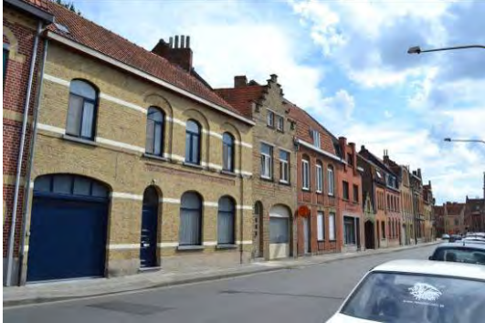
Figuur 3-12 Beeld van de woningen langs de Lange Torhoutstraat
