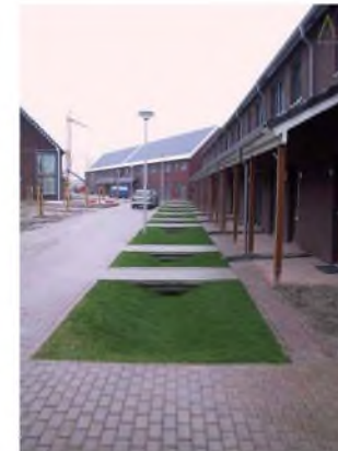
Figuur 4: bodempassage: groene goot in de Leidsche Rijn, NL (2003)
