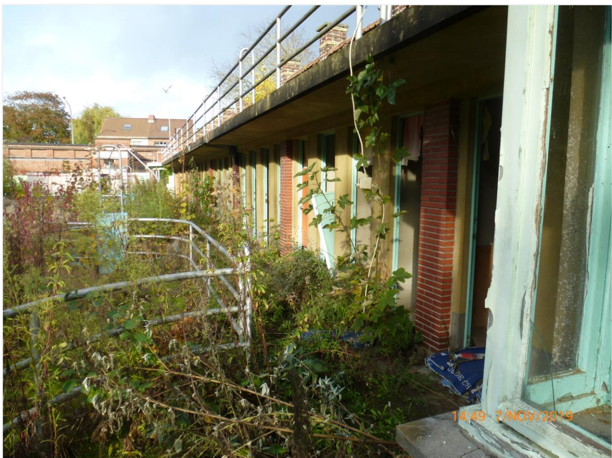
Foto 34: Zicht op kleedhokjes oostelijke afsluitingsmuur openluchtwembad Ieper (Stad Ieper 7 november 2019).
