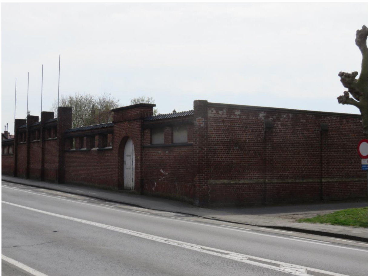
Foto 7: Noordelijke afsluitingsmuur openluchtzwembad Ieper (agentschap Onroerend Erfgoed 28 april 2021).
