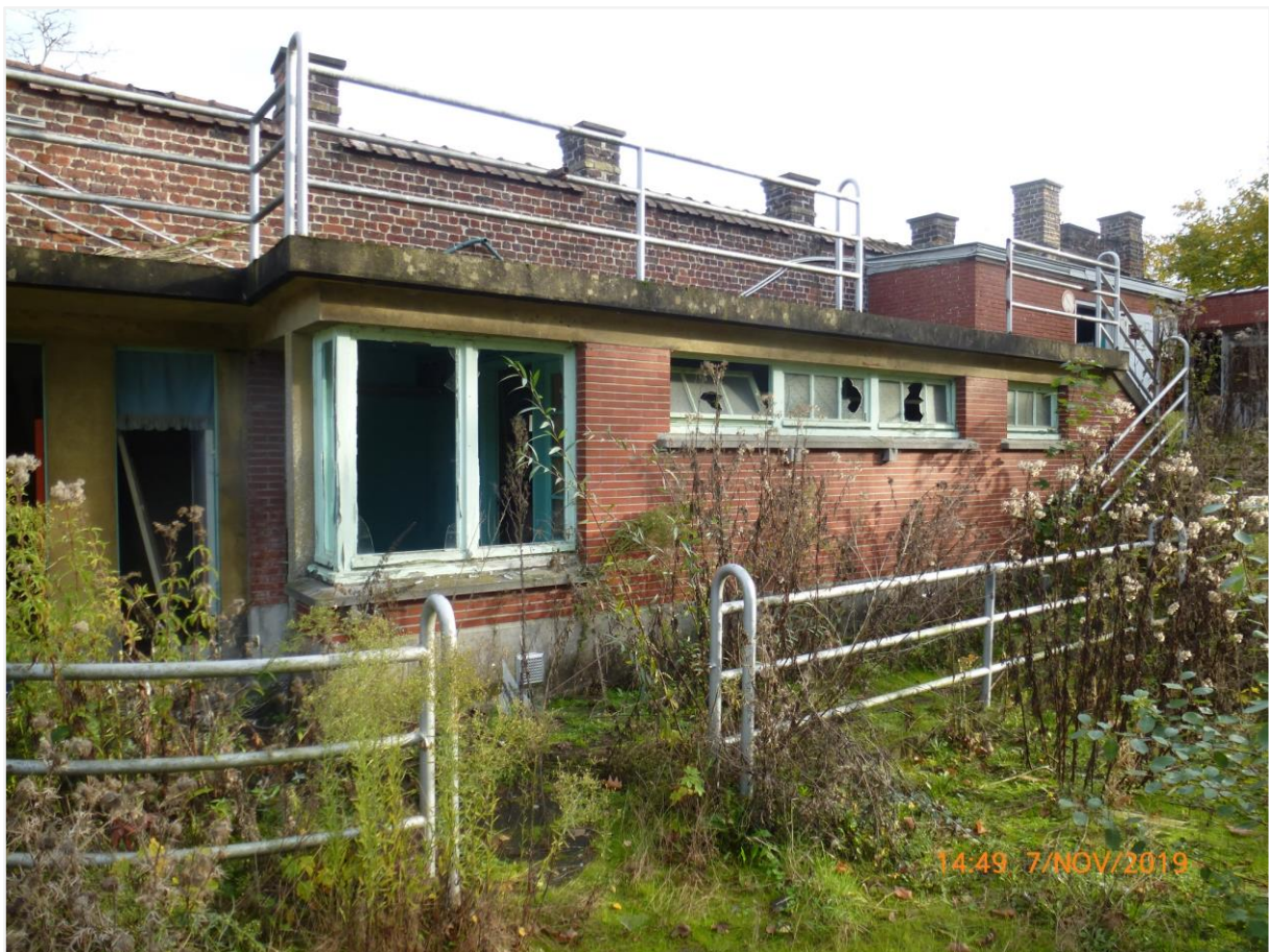
Foto 35: Zicht op sanitaire blok noordelijke afsluitingsmuur openluchtzwembad Ieper (Stad Ieper 7 november 2019).
