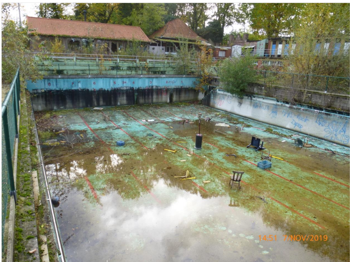
Foto 36: Zicht op grote kom van aan noordelijke zijde (Stad Ieper 7 november 2019).
