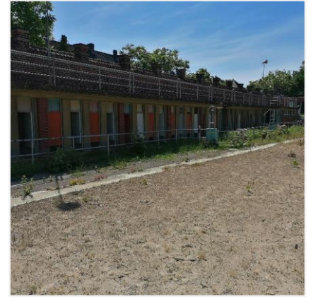
Foto 57: Overzichtsfoto openluchtwembad Ieper (Stad Ieper 8 juni 2021).
