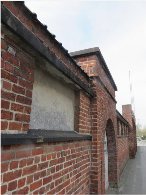
Foto 10: Detail noordelijke afsluitingsmuur openluchtzwembad Ieper (agentschap Onroerend Erfgoed 28 april 2021).
