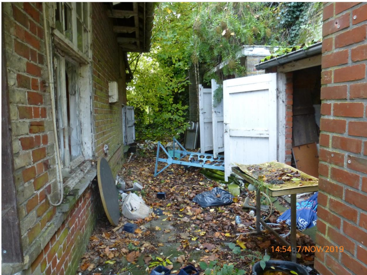
Foto 27: Westgevel voormalige conciërgewoning met sanitaire blok openluchtzwembad Ieper (Stad Ieper 7 november 2019).
