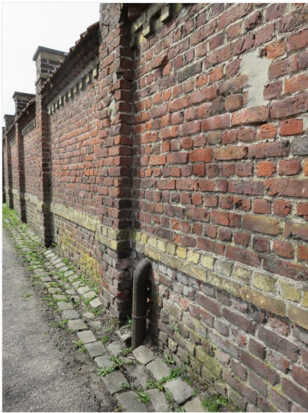
Foto 14: Detail oostelijke afsluitingsmuur openluchtzwembad Ieper (agentschap Onroerend Erfgoed 28 april 2021).
