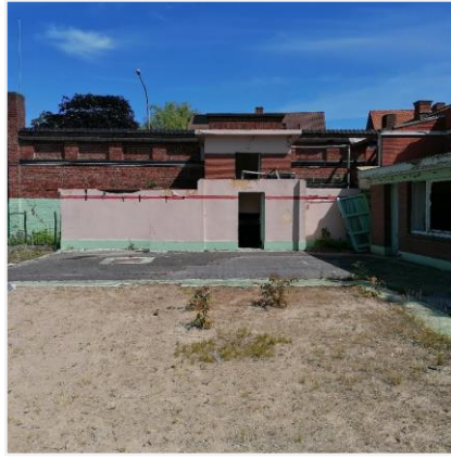
Foto 56: Noordelijke afsluitingsmuur openluchtwembad Ieper (Stad Ieper 8 juni 2021).
