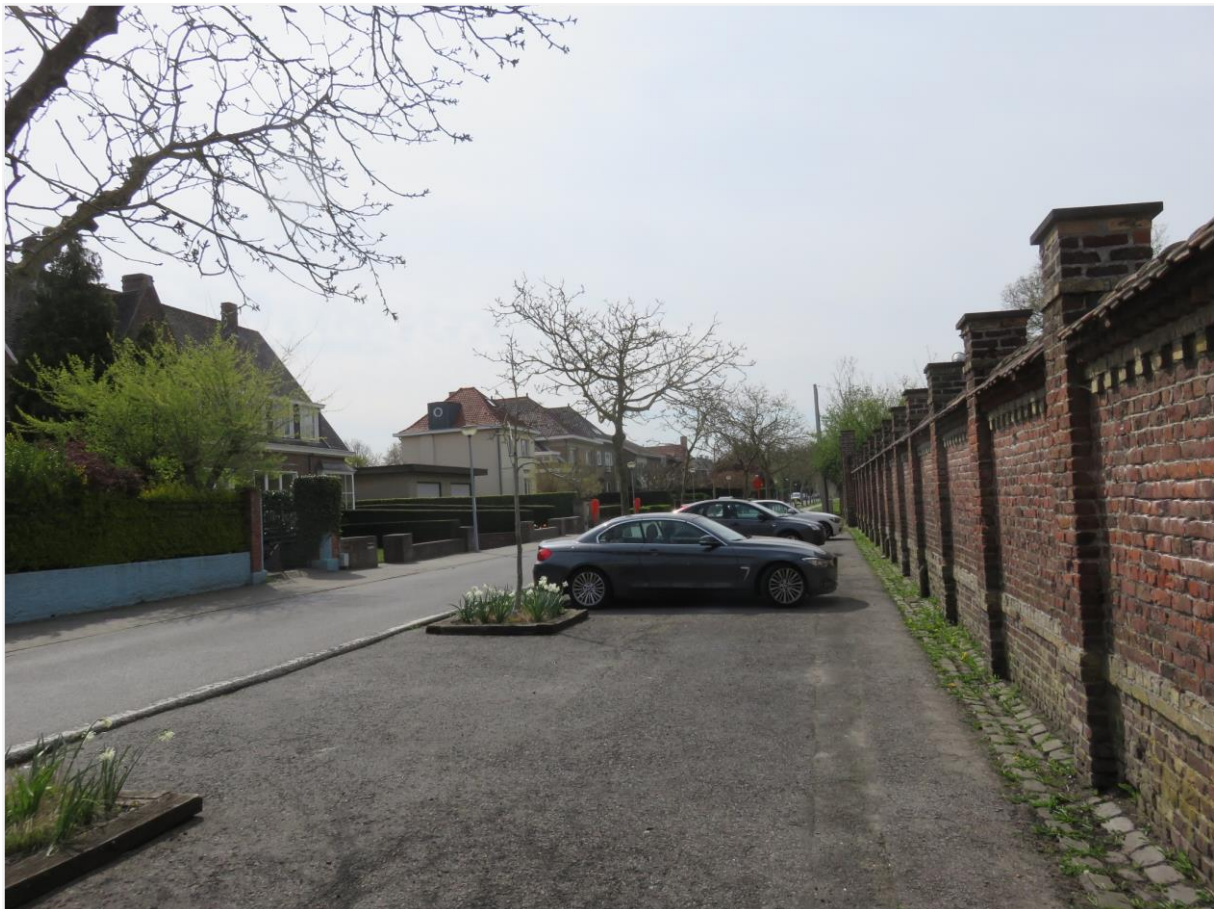
Foto 16: Oostelijke afsluitingsmuur openluchtzwembad Ieper ter hoogte van de Kiplinglaan (agentschap Onroerend Erfgoed 28 april 2021).
