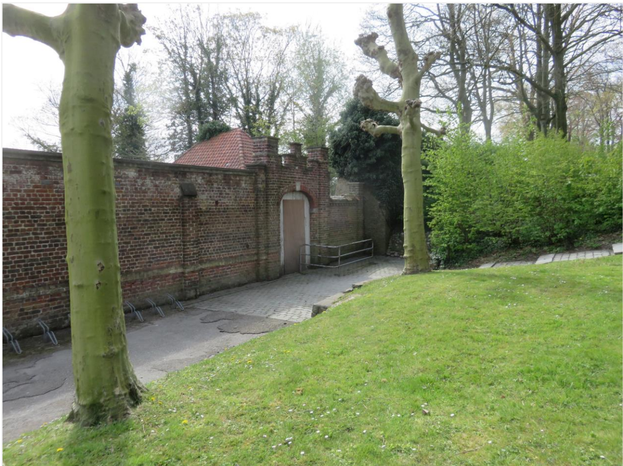
Foto 5: Zicht op toegangspoort westelijk afsluitingsmuur openluchtzwembad Ieper vanop de vestingen (agentschap Onroerend Erfgoed 28 april 2021).
