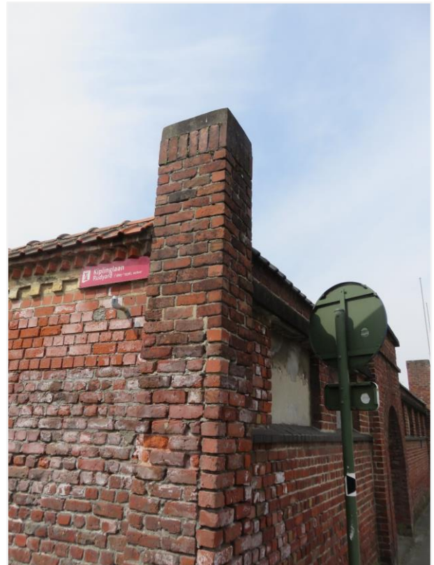
Foto 13: Detail noordelijke afsluitingsmuur openluchtzwembad Ieper (agentschap Onroerend Erfgoed 28 april 2021).
