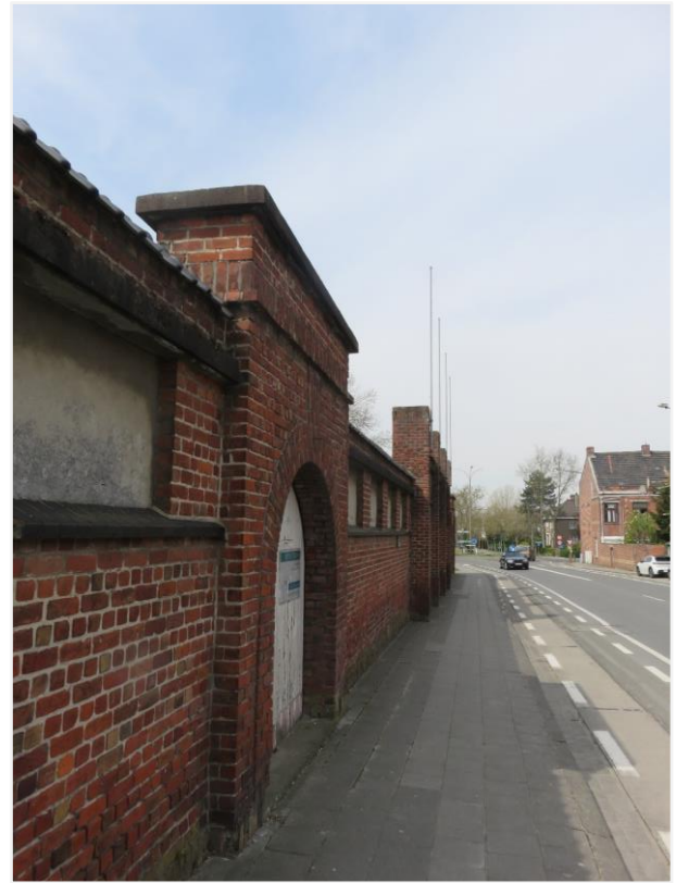
Foto 11: Noordelijke afsluitingsmuur openluchtzwembad Ieper (agentschap Onroerend Erfgoed 28 april 2021).
