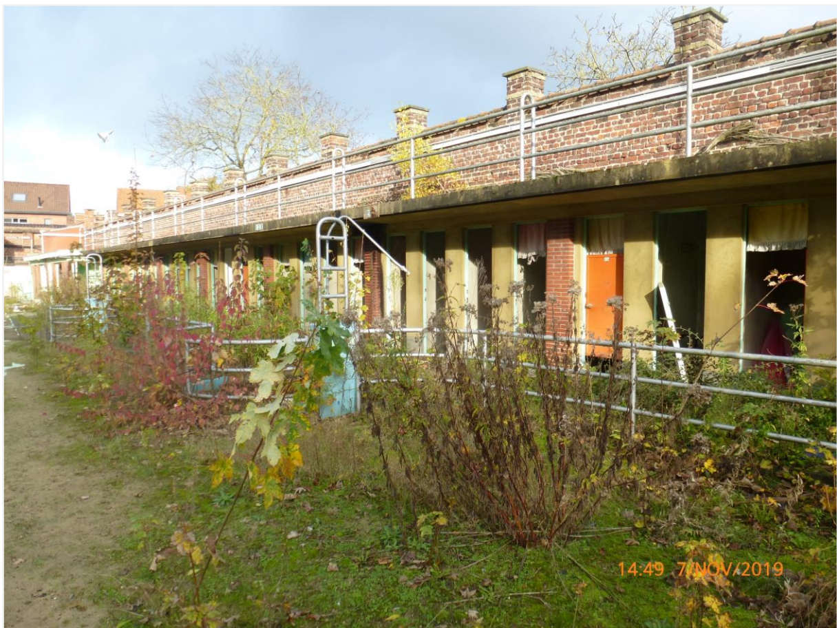
Foto 33: Zicht op kleedhokjes oostelijke afsluitingsmuur openluchtwembad Ieper (Stad Ieper 7 november 2019).
