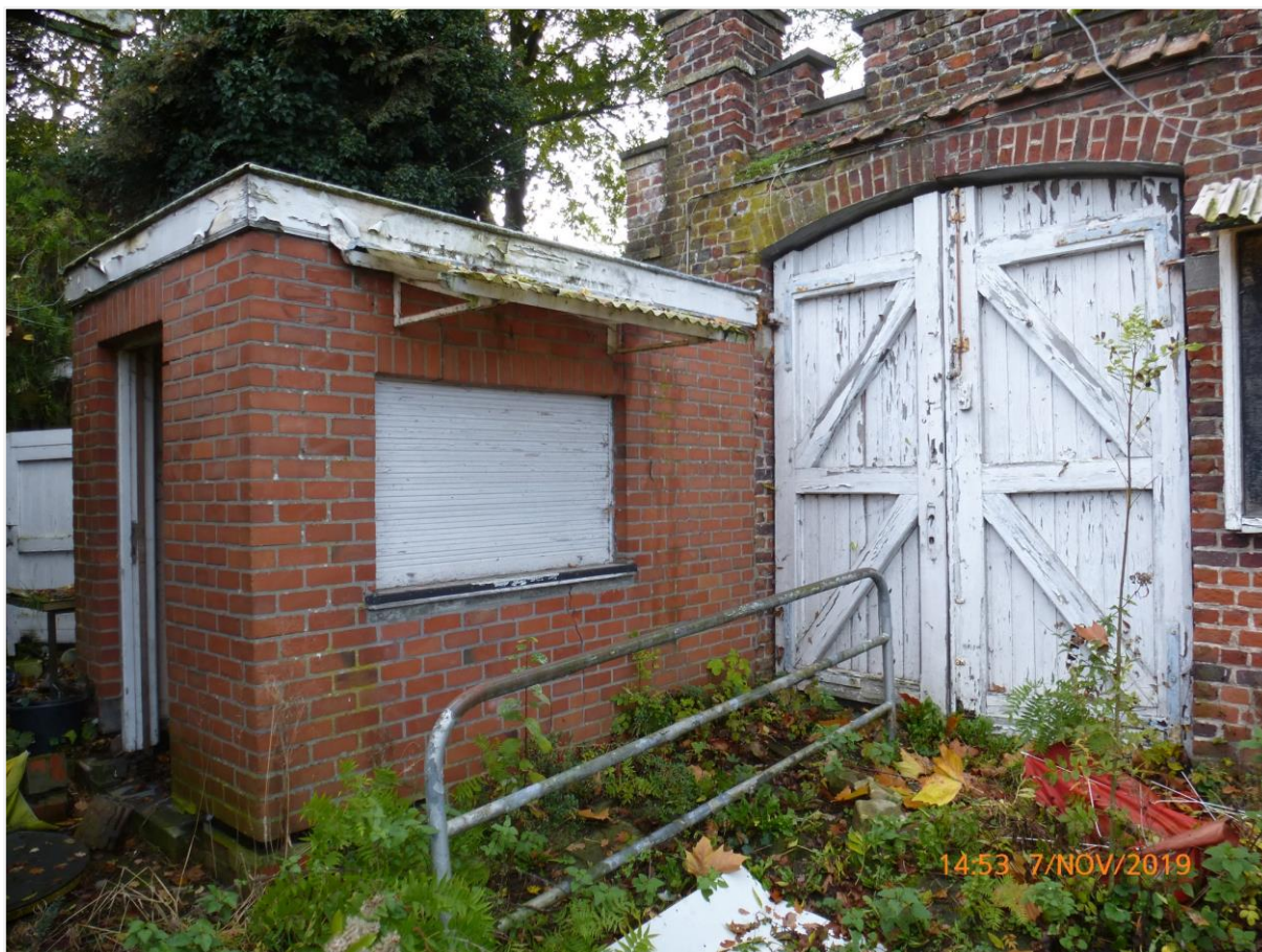
Foto 25: Zicht op toegangspoort (binnenzijde) westelijke afsluitingsmuur openluchtzwembad Ieper (Stad Ieper 7 november 2019).
