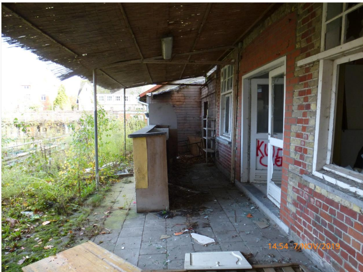
Foto 28: Noordgevel voormalige conciërgewoning openluchtzwembad Ieper (Stad Ieper 7 november 2019).
