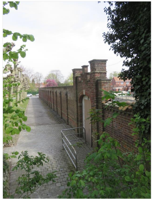
Foto 2: Westelijke afsluitingsmuur openluchtzwembad Ieper ter hoogte van de Lange Torhoutstraat (agentschap Onroerend Erfgoed 28 april 2021)
