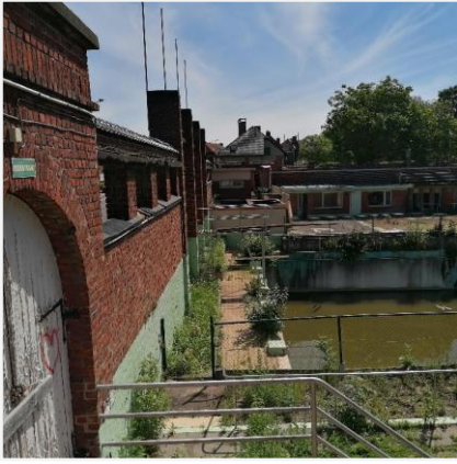
Foto 55: Noordelijke afsluitingsmuur openluchtwembad Ieper (Stad Ieper 8 juni 2021).
