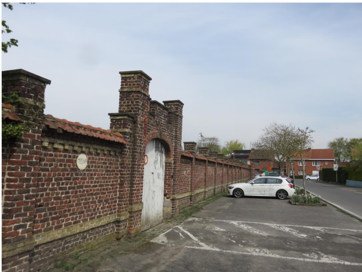
Foto 18: Oostelijke afsluitingsmuur openluchtzwembad Ieper ter hoogte van de Kiplinglaan (agentschap Onroerend Erfgoed 28 april 2021).
