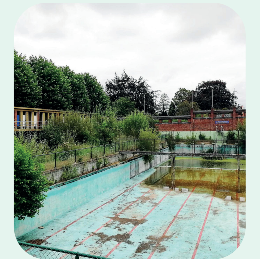
Het voormalige openluchtzwembad anno 2022 ©B-juxta
