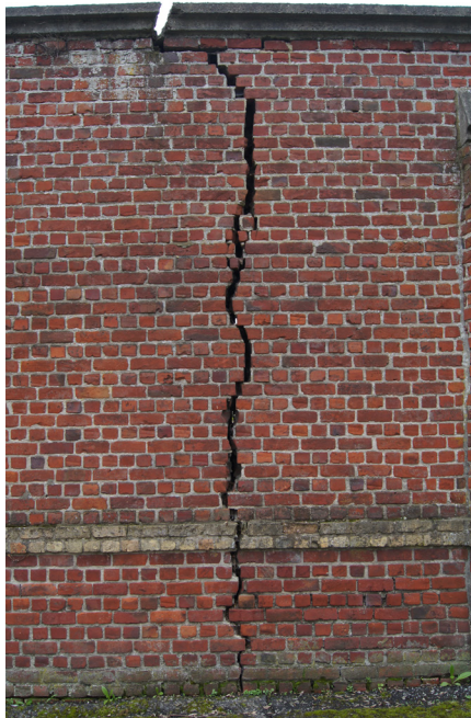
Barst thv saillant ondergrondse vestingmuur
