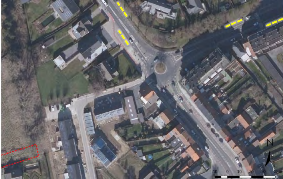
Figuur 121: 2 x dubbel bushalte 'leper Hoekje' in de Veurnseweg en de Oude Veurnestraat (Orthofoto, februari 2019)
