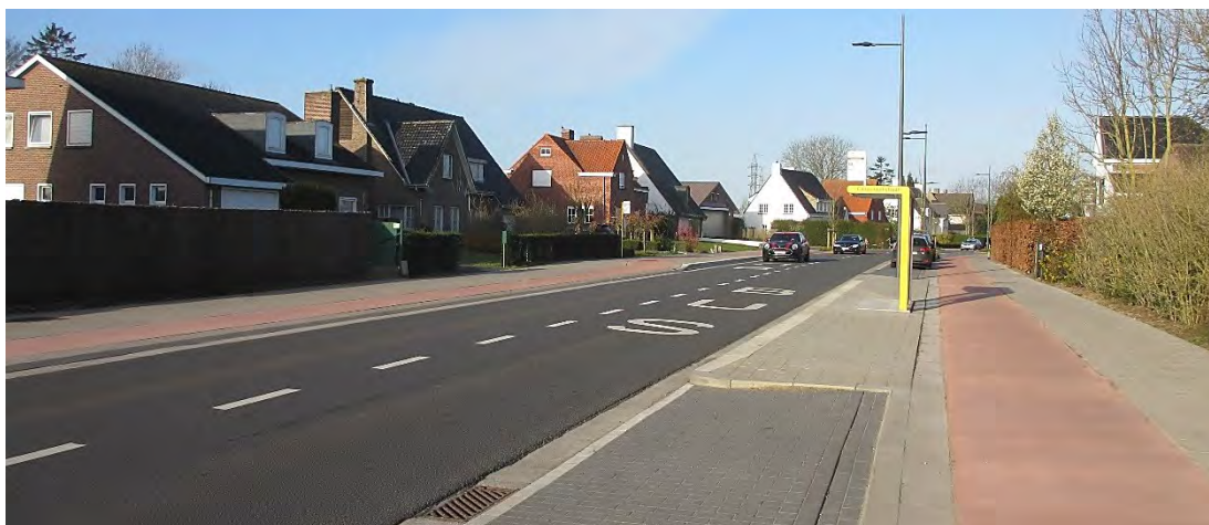
Figuur 28: N308 (Poperingseweg) (Eigen foto, februari 2019)
